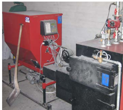
Rapskage-fyret stokerfyr.
