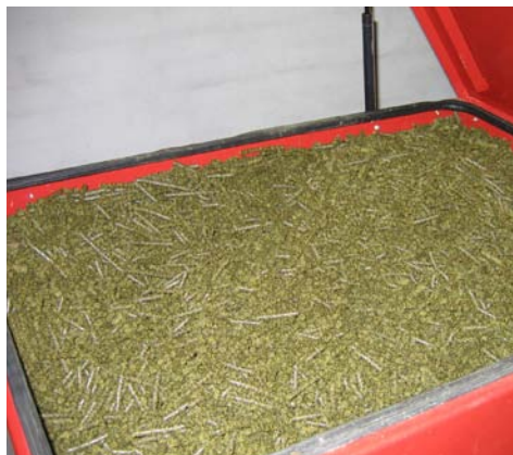
Rapskage-piller i magasin på stokerfyr.
